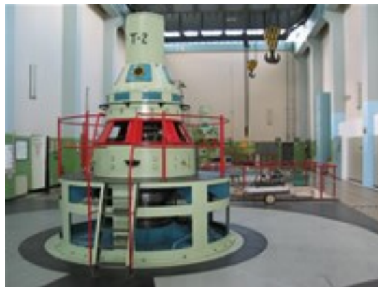
Rys. 7. Typowy hydrozespół z turbiną Kapłana przedstawia xxix
